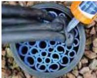
4. Mediante el uso de un paño húmedo, empujar el sellador alrededor de los cables. Asegurarse de que se aplica una cantidad suficiente de sellador y que hace buen contacto con todas las superficies.
