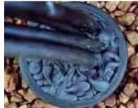
5. Con las manos (se recomienda el uso de guantes de nitrilo), asegurarse nuevamente de que existe suficiente cantidad de sellador entre los cables y se ha conseguido el espesor requerido. Se recomienda mojar los guantes para evitar que el sellador se pegue a los mismos, y suavizar el acabado exterior hasta que quede totalmente liso.
