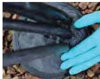
6. Realizar una comprobación final con un punzón para asegurar que se ha aplicado sellador entre todos los cables. El tiempo de curado del sellador es de una media de 2mm por día.
