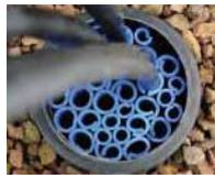
3. Aplicar 20mm de sellador en la cara exterior de la embocadura, empezando por las zonas de mayor dificultad (donde se ubican los cables) y posteriormente ir llevándolo hacia el resto de la embocadura. Se recomienda un ligero sobrellenado de la embocadura.
